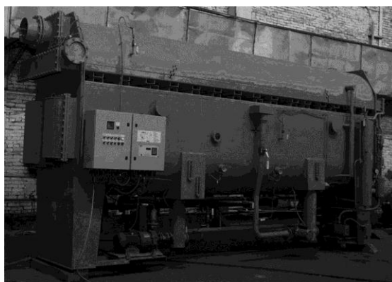
Рис. 9. АБХМ с одноступенчатой регенерацией раствора
